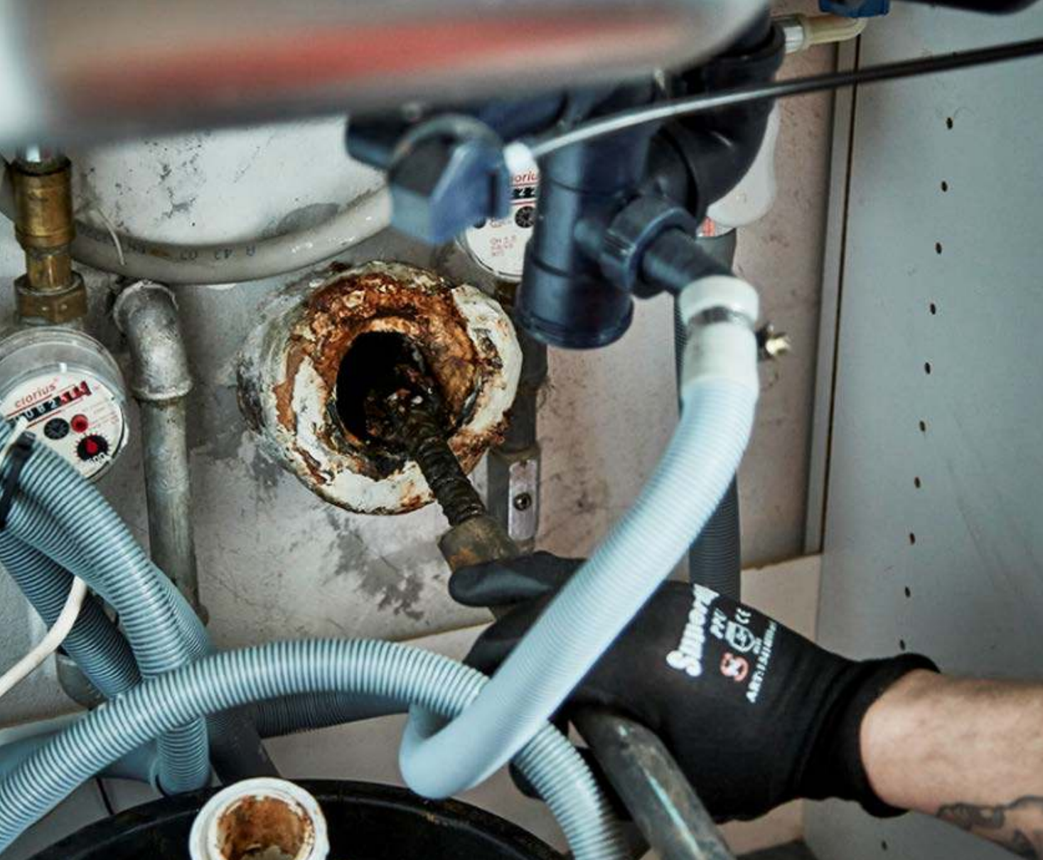
Faldstammen renses mekanisk med en lang kæde, hvorpå der er monteret "knive", som fjerner alt skidt og aflejringer.
