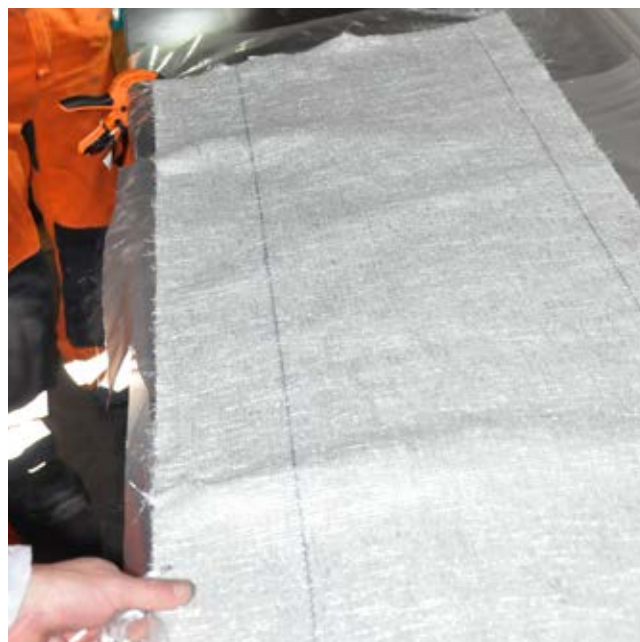
Glasfiber dugen rulles ud og gøres klar til imprægnering, inden den monteres i ledningen.
