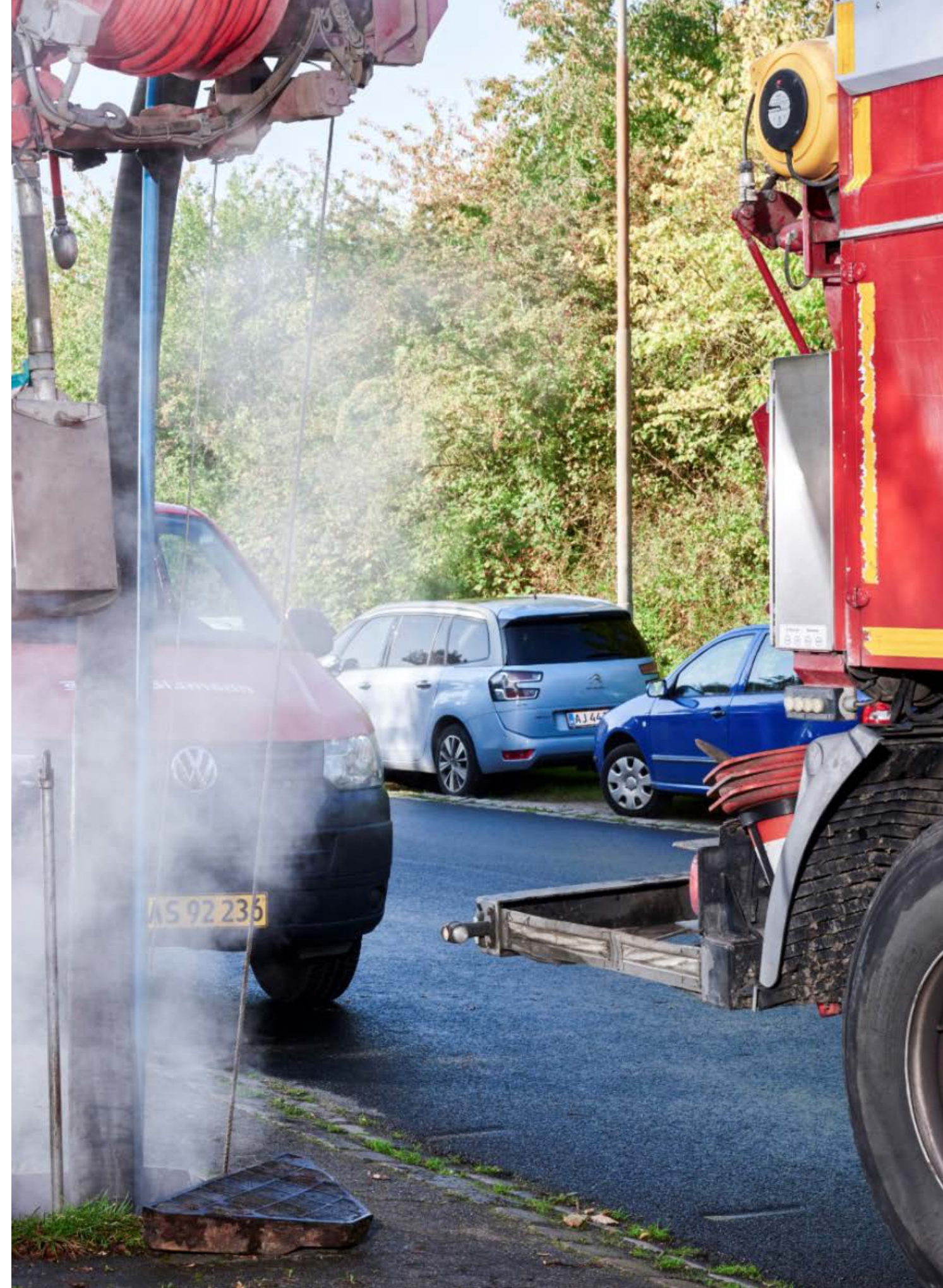
Genbrugsspuleren opsamler sit eget spulevand og sparer både tid og ressourcer. Spuleren kan arbejde i samme brønd i længere tid, uden at skulle hente "nyt" spulevand.
