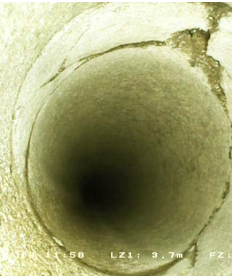
Før renoveringen af ledninger
