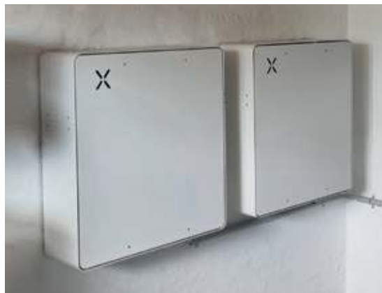
To af foreningens 6 XOLTA solcellebatterier der lagrer solenergi fra det nye tag.
