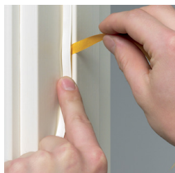
Montering af tætningsliste
