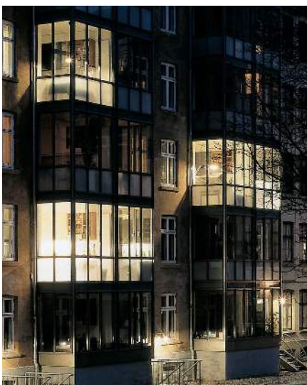
Hedebygade, Vesterbro Glastilbygninger med nye køkken-almur
