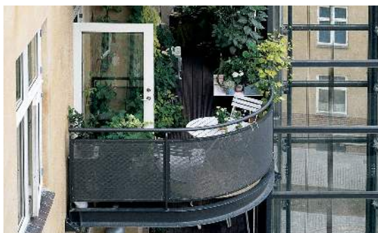
Wilkensvej, Frederiksberg Elevatortårn og nye altaner
