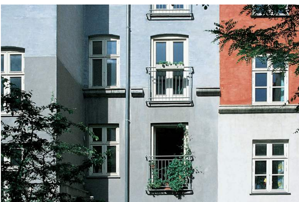
Trepkagade, København Facaderenovering og nye franske altaner
